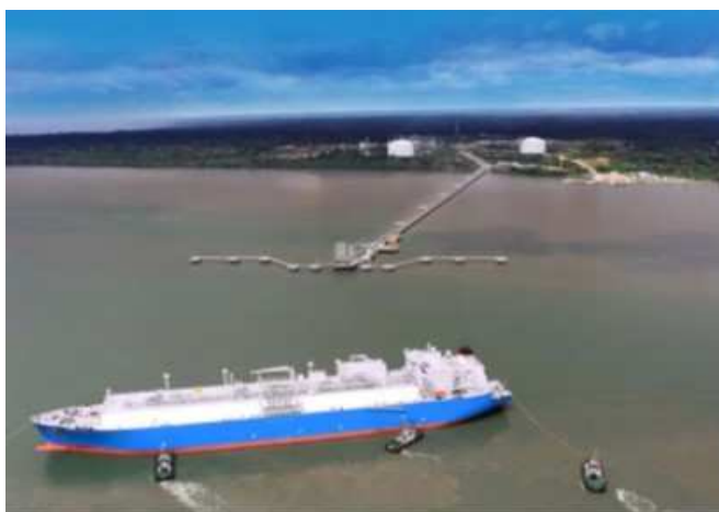
図 7.3 Tangguh LNG Project 出荷第1船
