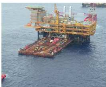
フロートオーバー方式による設置
