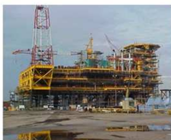
ドックでのトップデッキ建造
